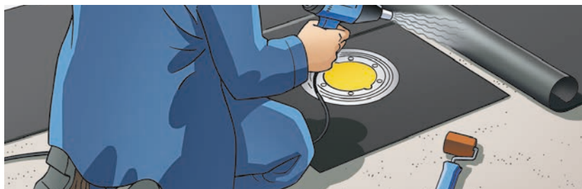
3 – 21 ábra. Az EPDM tömítőcsikok forrasztása gázégővel
